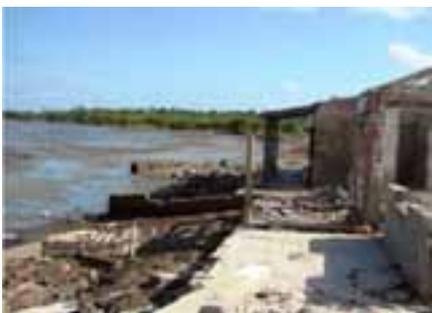
Destrucción de las obras costeras por la elevación del nivel del mar, la mala ubicación de las construcciones y la acción del oleaje.
